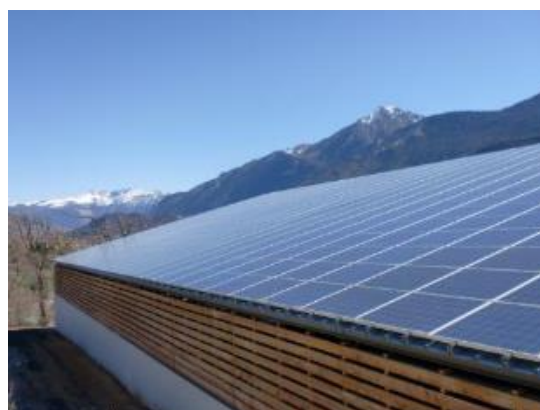
Centrale photovoltaïque en toiture d'Embrun exploitée par JPEE
