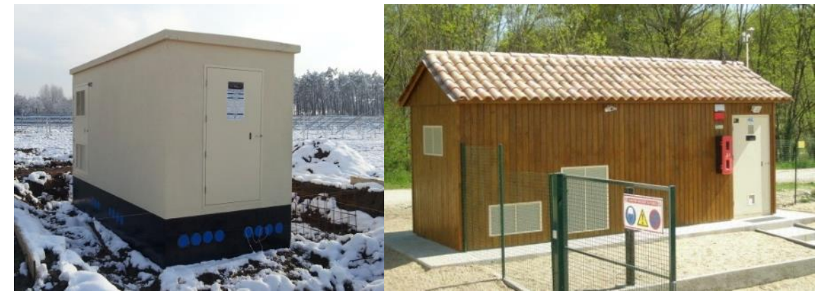
Exemples de postes de transformation (source : JPEE)
