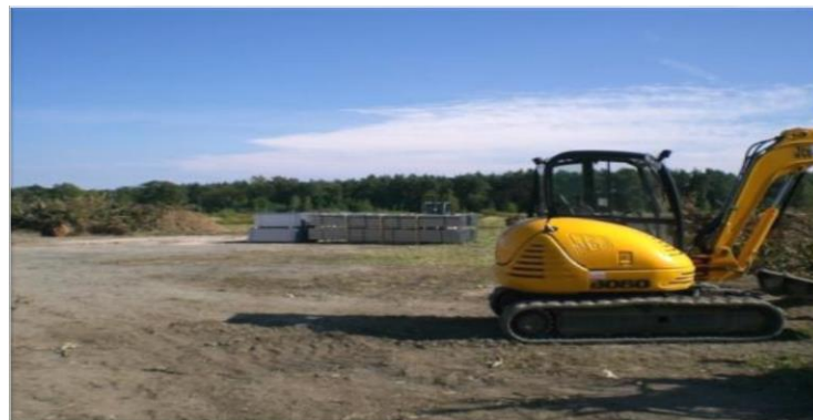
Exemple de terrassement (Source : JPEE)
